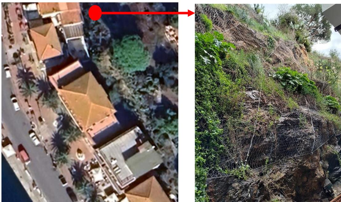
Il rafforzamento corticale avviene oltre che con la rete con l'inserimento di ancoraggi puntuali in grado di migliorare la stabilità della coltre superficiale alterata e trattenere il detrito e/o blocco tra gli ancoraggi.
