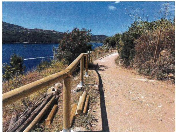
In tale occasione si è inoltre verificata la necessità di eseguire ulteriori interventi urgenti di manutenzione straordinaria su alcuni tratti di staccionata in legno, in quanto alcune parti del tratto risultavano prive di staccionata oppure la stessa risultava danneggiata, per un totale di ulteriori 200 ml. (come da documentazione fotografica di seguito riportata).
