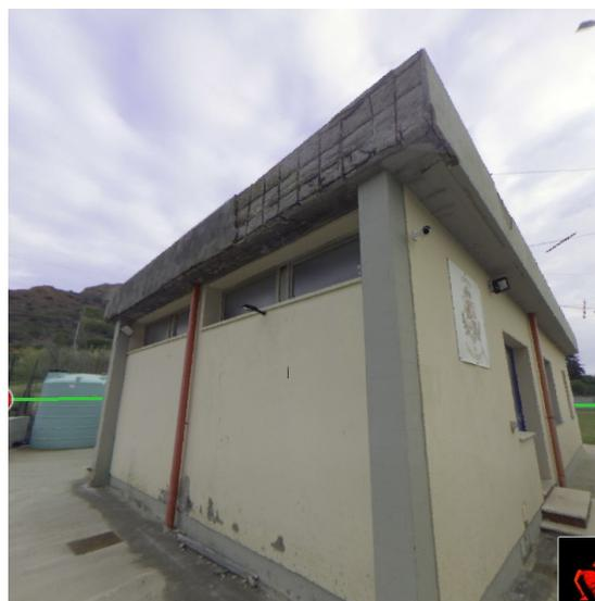
Solaio in stato di degrado causato da infiltrazioni di acque meteoriche,
