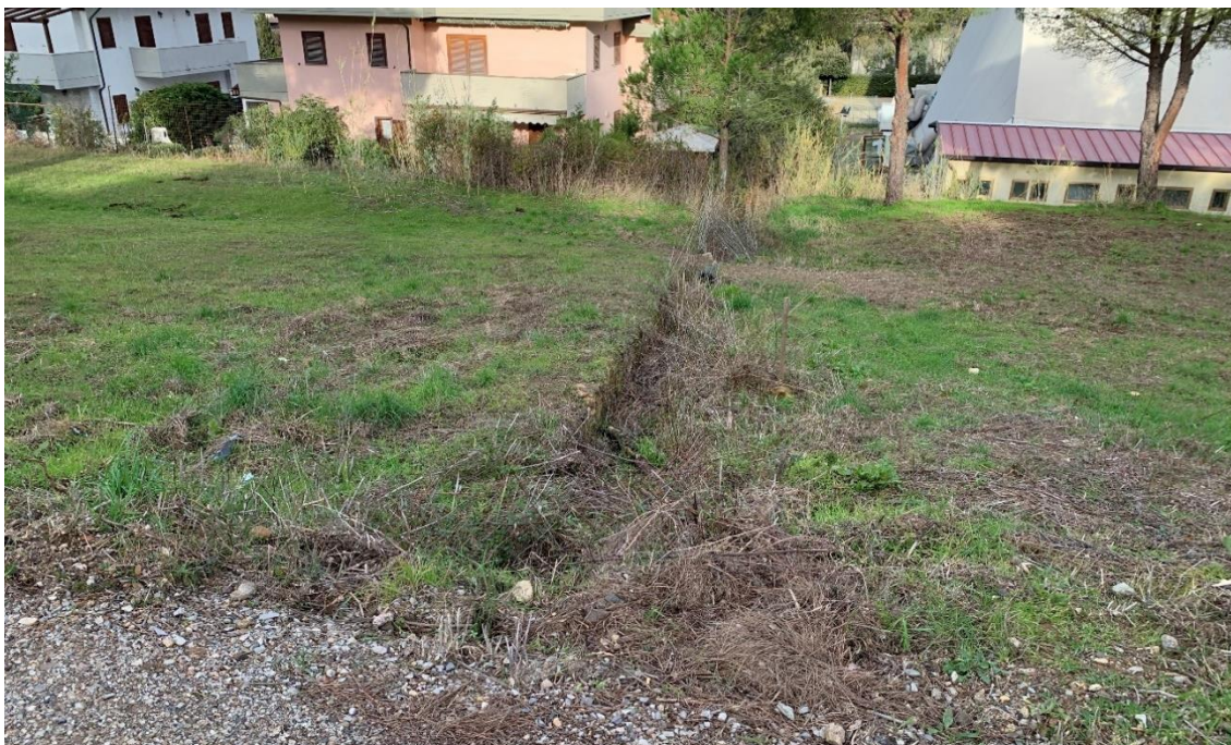
Canale di scolo a cielo aperto – Parcheggio 1
