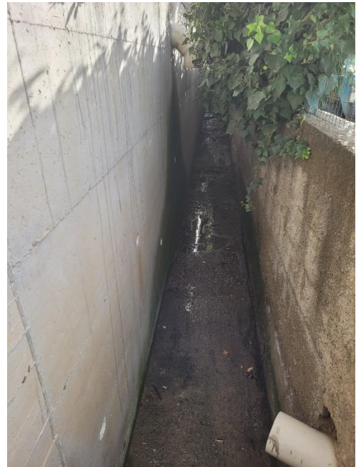
TRATTO CON CANALE IN C.A.
