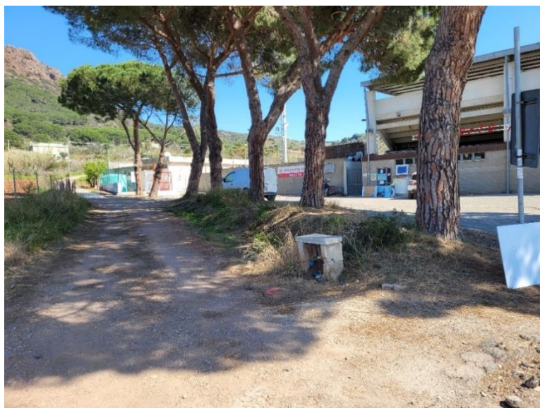
Strada che conduce alla proprietà privata con evidenza della traccia del canale esistente che risulta tombato nella parte terminale
