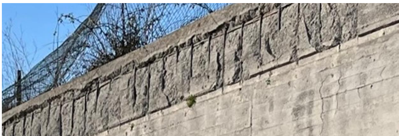
Figura 3 Muro di sostegno nello stato attuale, dettaglio parte sommitale mensola in elevazione
