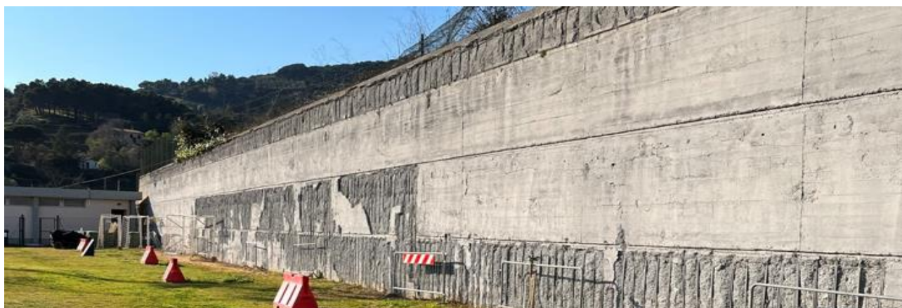
Figura 1 Muro di sostegno nello stato attuale, vista d'insieme
