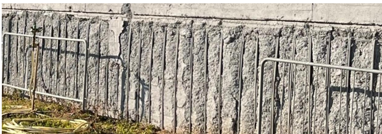
Figura 2 Muro di sostegno nello stato attuale, dettaglio base mensola in elevazione
